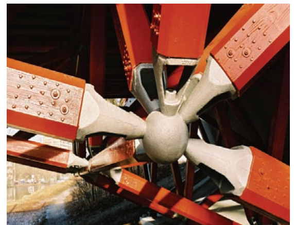
Figure 3. Assemblage à chevilles en acier
